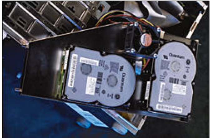
AST:n levyt on asennettu omintakeisesti sivupaneeliin.
